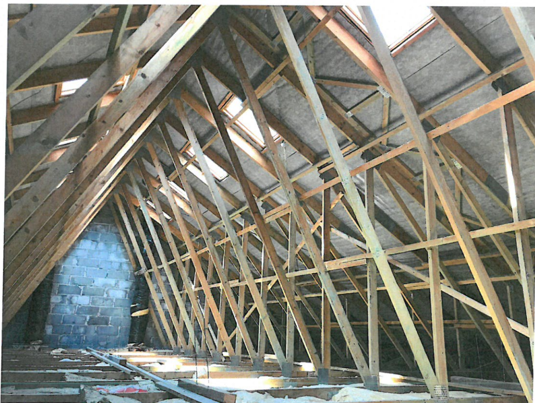
Fotografia 2 – Prefabrykowany więzar dachowy
