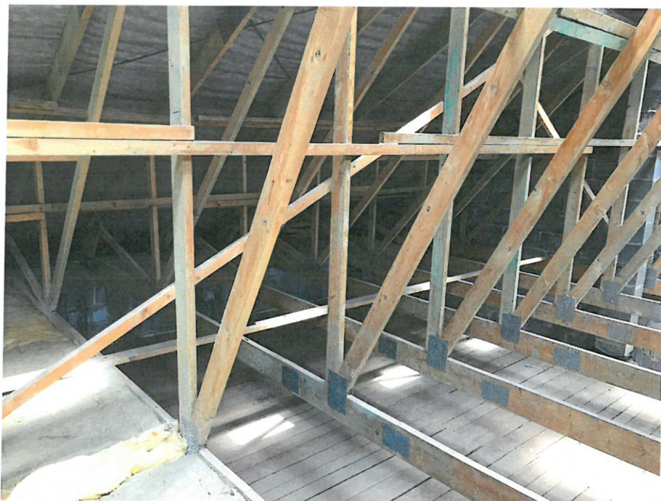
Fotografia 3 – Prefabrykowany więzar dachowy
